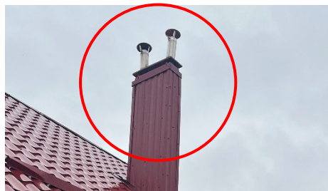
установка зонтов на дымовых каналах
