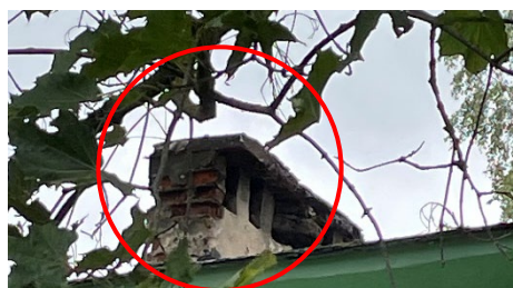
разрушенный оголовок дымовых и вентиляционных каналов
